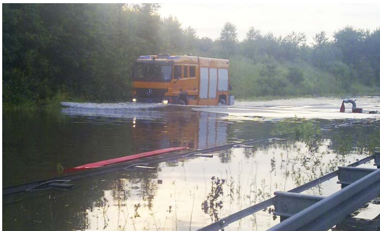
Oversvømmelse af Amagermotorvejen ifm. kraftig nedbør juli 2011, hvor Beredskabsstyrelsen var med til at sikre indfaldsvejene til København.
