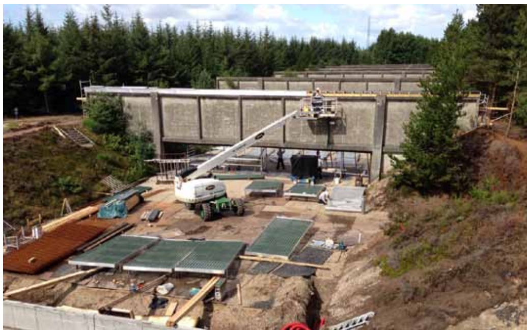
Støjdæmpning og modernisering af Varde skydebaner.
