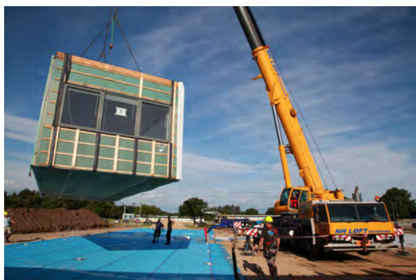
Opførelse af pavillonbyggeri.
